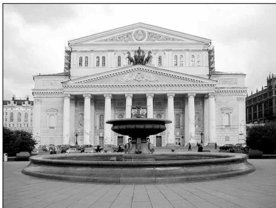
Рис. IV-36. Фронтальная композиция для съемки этого здания — оптимальное решение
